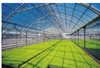
苗床のハウスは自動かん水。種モミが柔らかい時期は、スズメ対策と保温にネットも使用。
